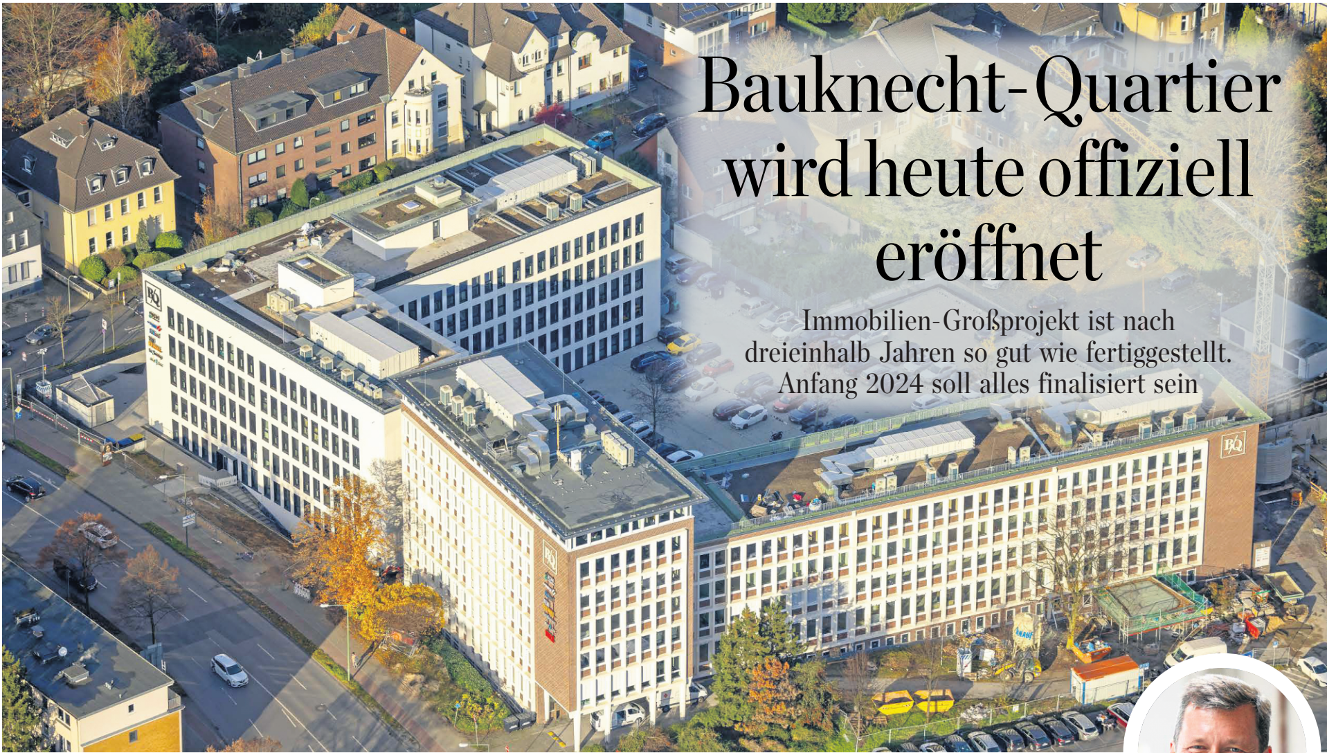
Das Bauknecht-Quartier am Gleiwitzer Platz steht kurz vor der Fertigstellung.
